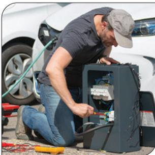
Installez le socle pré-câblé sur le site.
