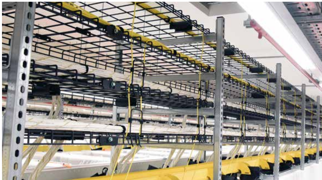
bijschrift Foto kabelgoten) Cebeo dacht ook mee aan een geschikt kabeldraagsysteem. De goten moesten voldoende breed zijn en over een enorme draagkracht beschikken. Zeker voor de koperkabels. Data- en voedingskabel lopen gescheiden: power gaat onder de rack, datakabel boven de rack.
