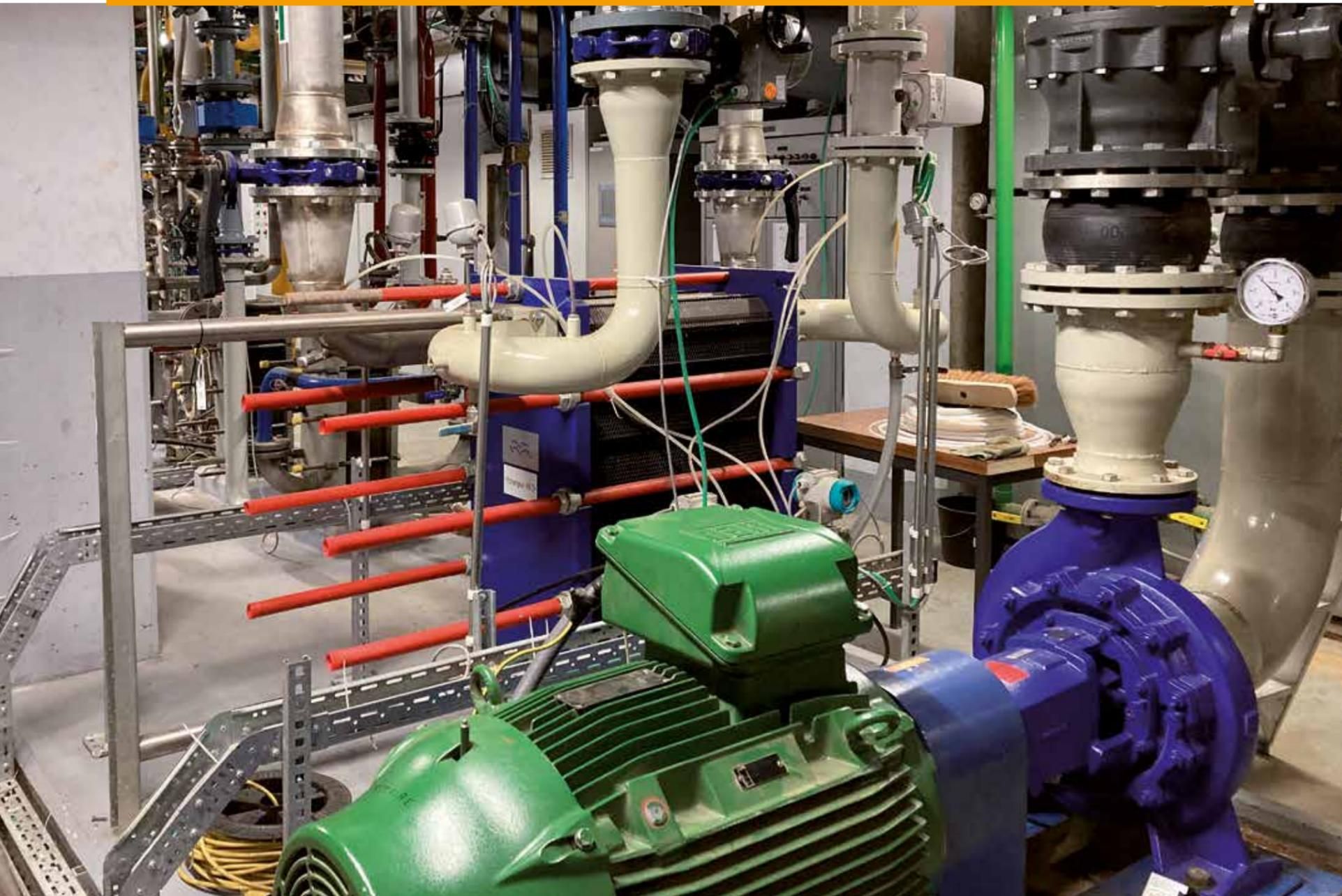
Construit entre 1970 et 1972, le Cyclotron fut le tout premier bâtiment achevé de Louvain-la-Neuve. Pour son bon fonctionnement, l'accélérateur de particules qu'il abrite nécessite une grande capacité de refroidissement. En régulant le système de refroidissement, le Centre de Ressources du Cyclotron (CRC) de l'UCLouvain est en passe d'économiser environ 400MWh d'électricité par an. L'investissement en matériel sera ainsi récupéré en une seule année...
