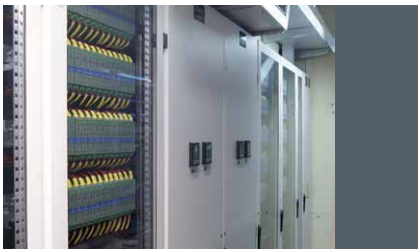
Beveiligingskasten met de UPS'en en verdeelborden
