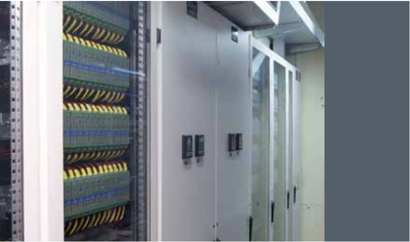
Armoires de protection avec les UPS et les tableaux de distribution
