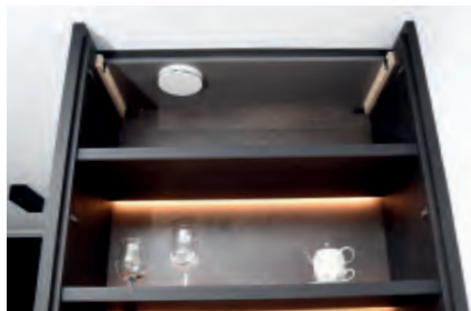
In deze kast wordt het ventiel op subtiel manier weggewerkt door een demonteerbaar schap.
