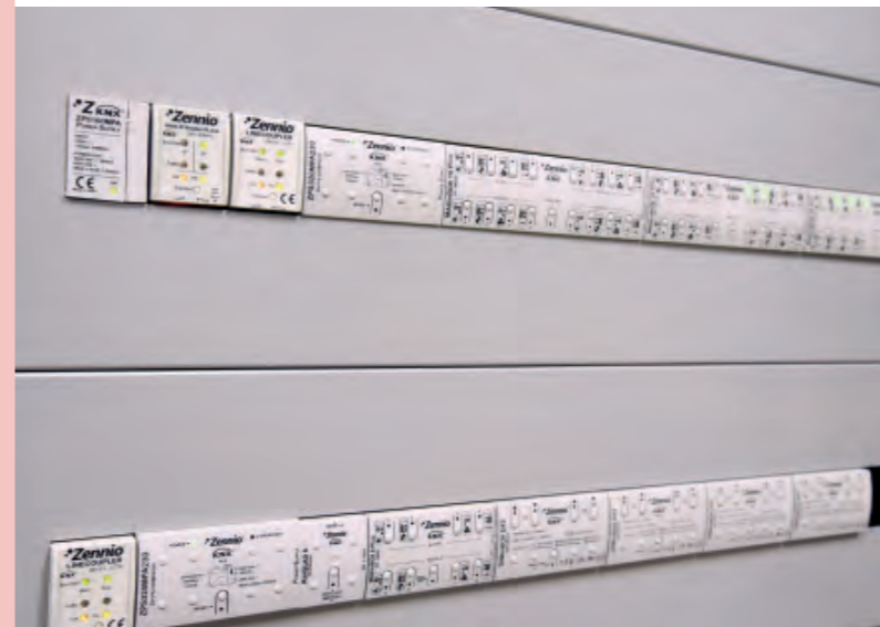
Verlichting en screens worden al aangestuurd door de Zennio KNX-modules.
